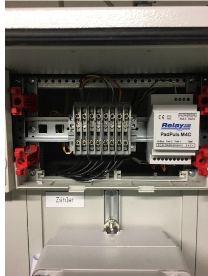
Abbildung 27 (EVU- Impulsbereitstellung + Imp./M-Bus Wandler)
